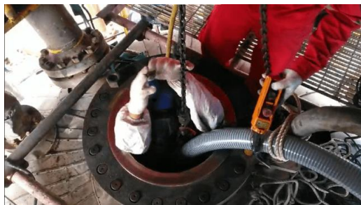
Gambar 1 Dokumentasi observasi lapangan saat pekerja masuk melalui manhole
